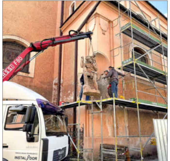
Wie hier der Heilige Christopherus, werden aktuell alle Sandsteinfiguren an der Außenwand der Minoritenkirche entnommen und zum Restaurieren gebracht. Die Figuren standen bei der Flutkatastrophe unter Wasser. Kaum zu glauben, wenn man bedenkt, dass das Flussbett der Neiße noch einmal 5 Meter tiefer liegt als der Klostergarten.
