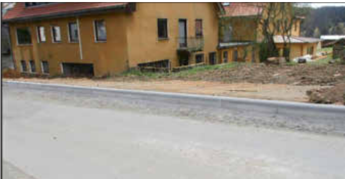
Hermes während der Baumaßnahme.
