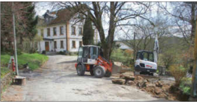
Hermes während der Baumaßnahme.
